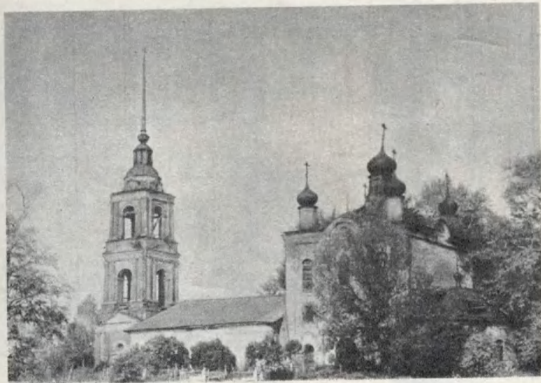
Церковь Введения в селе Байловском. 1797, перестроена в конце XIX в.
